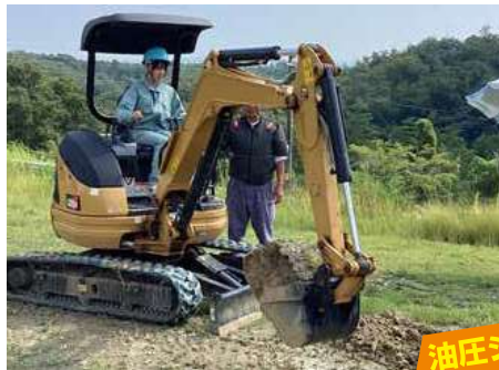
建設重機を体験
