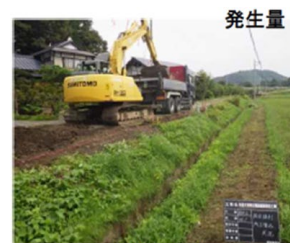
(甲) 道路舗装工事
