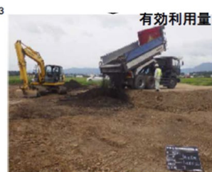
(乙) 農地整備工事
