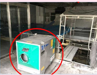
集塵機を設置し室内の換気を実施
