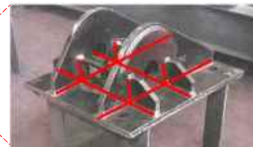
— 完全溶け込み溶接部
