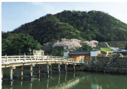
所在地/鳥取県 竣工日/2019年3月29日
