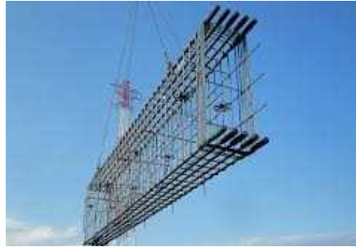
梁鉄筋地組取付
