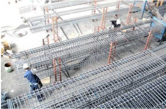
梁鉄筋工場地組
