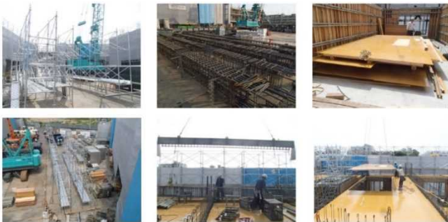
地組(足場・型枠・鉄筋)のイメージ
