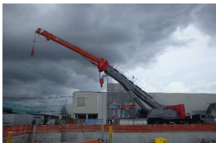
ラフタークレーンによる施工
