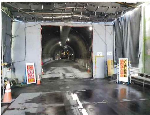
平原五條線(仮称)栄山寺トンネル工事現場
