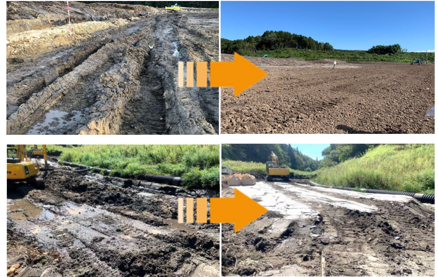
(例) タイ王国における日本の新技術による地盤改良
