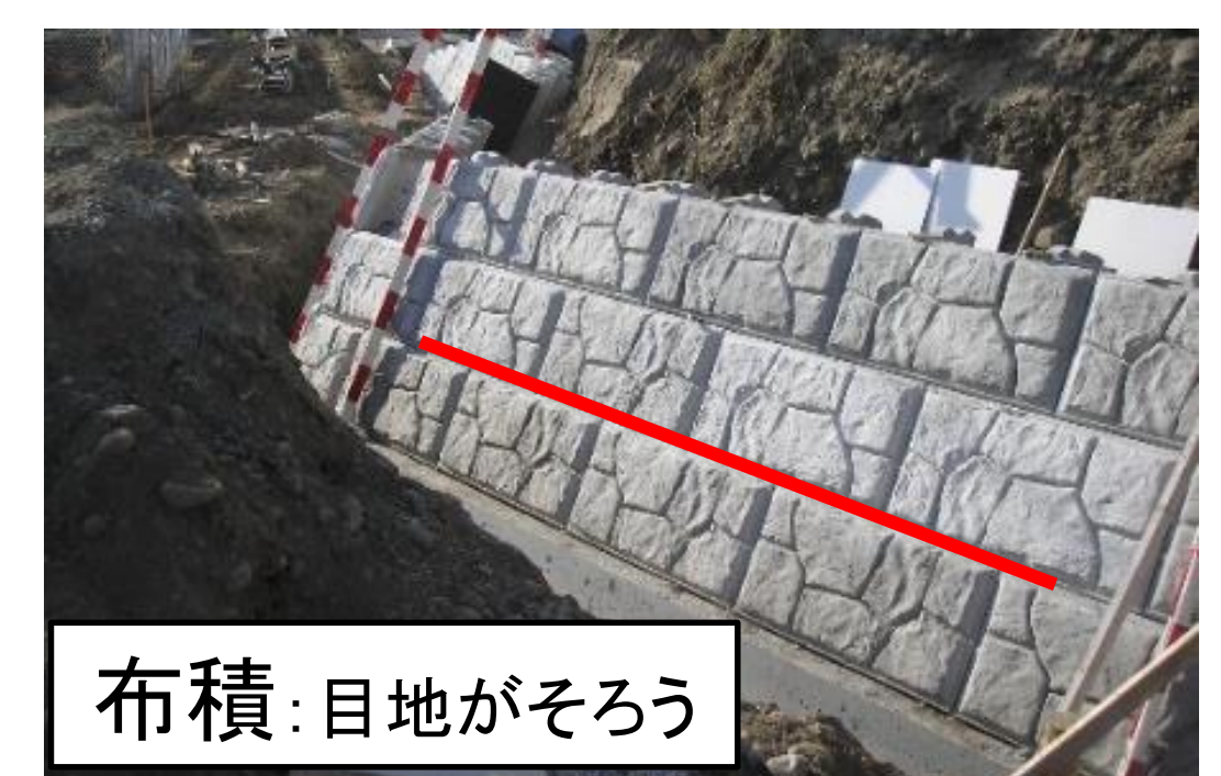
図2 控長35cmのまま大型化したブロックを布積にした形式
