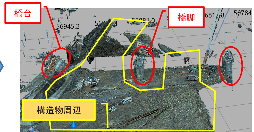
点群取得のイメージ（橋脚全体の点群）
