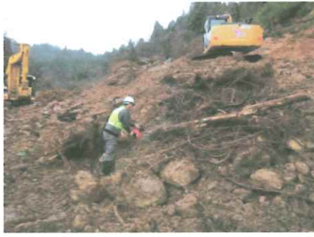
輪島市三井町地内 道路啓開
