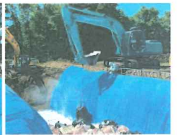
栃木県内豚熱発生に係る掘削、埋却、埋め戻し、消石灰の散布
