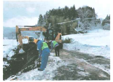
輪島市町野町金蔵地内 道路啓開
