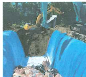
栃木県内豚熱発生に係る掘削、埋却、埋め戻し、消石灰の散布
