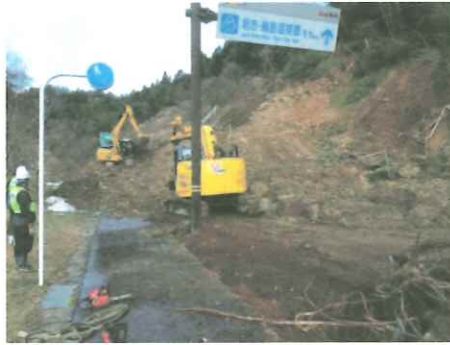
輪島市三井町地内 道路啓開
