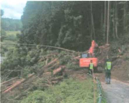
輪島市門前町地内 道路啓開
