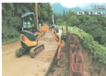
国道47号舟形町 矢板打設、盛土
