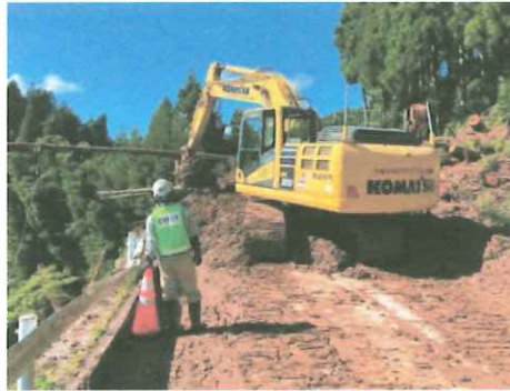
輪島市門前町地内 道路啓開
