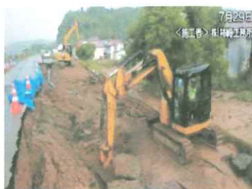
国道47号戸沢村 被災構造物撤去
