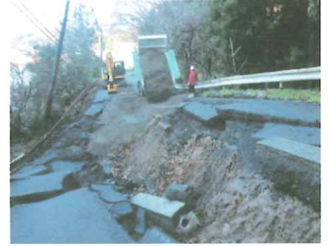
鳳珠郡穴水町川尻地内 道路啓開
