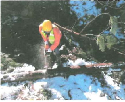
輪島市門前町二又川地内 道路啓開
