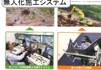
熊谷組・無人化施工システム
