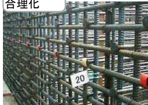
清水建設・Tヘッド工法鉄筋
