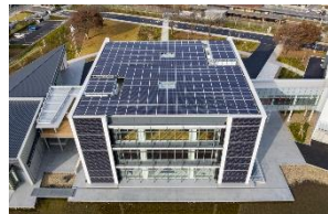
前田建設工業・ZEB新築 (ICI LAB エクスチェンジ棟)
