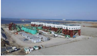
りんかい日産建設・ 高圧フィルタープレス脱水処理工法
