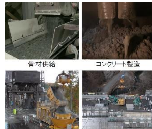
清水建設・ダムコンクリート自動打設システム
