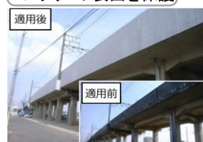
大林組・スムーズボード工法
