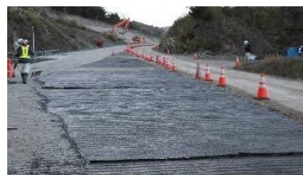
清水建設・バイオ炭コンクリート
