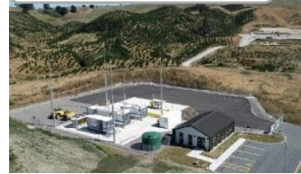
大林組・水素サプライチェーン構築 (◆)
