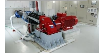
飛島建設・小水力発電
