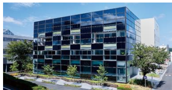
大成建設・ZEB実証棟
