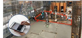
西松建設・ コンクリート打設数量管理システム
