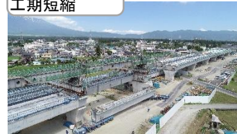
三井住友建設・U桁リフティング架設工法
