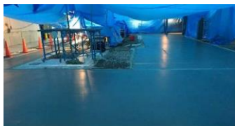
前田建設工業・ スーパーグリーンコンクリート
