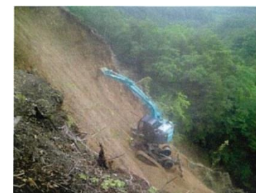
長大法面工事
