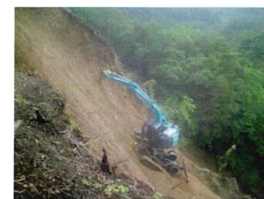
長大法面工事
